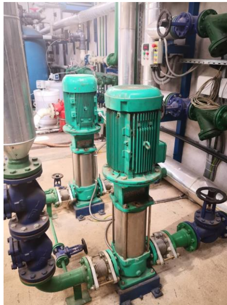
Slika 8. Sistem za održavanje pritiska u vrelovodnom sistemu
