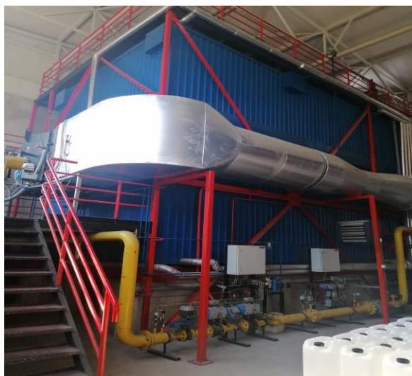
Slika 2. Vrelovodni kotao 1
