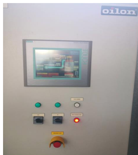
Slika 15. Upravljački sistem gorionika PLC-G1
