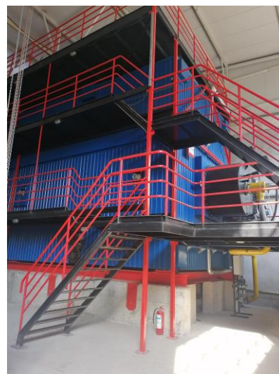
Slika 3. Vrelovodni kotao 2
