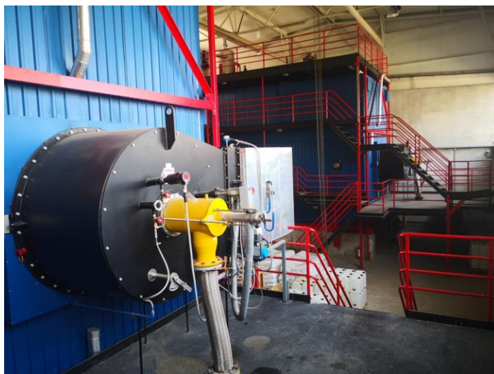
Slika 5. Gorionici na kotlovima
